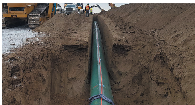
Рисунок 14. Укладка трубопровода с закреплённым оптоволоконным кабелем чувствительного элемента (оранжевый). Фото из журнала Pipeline Technology Journal #2/2021.
